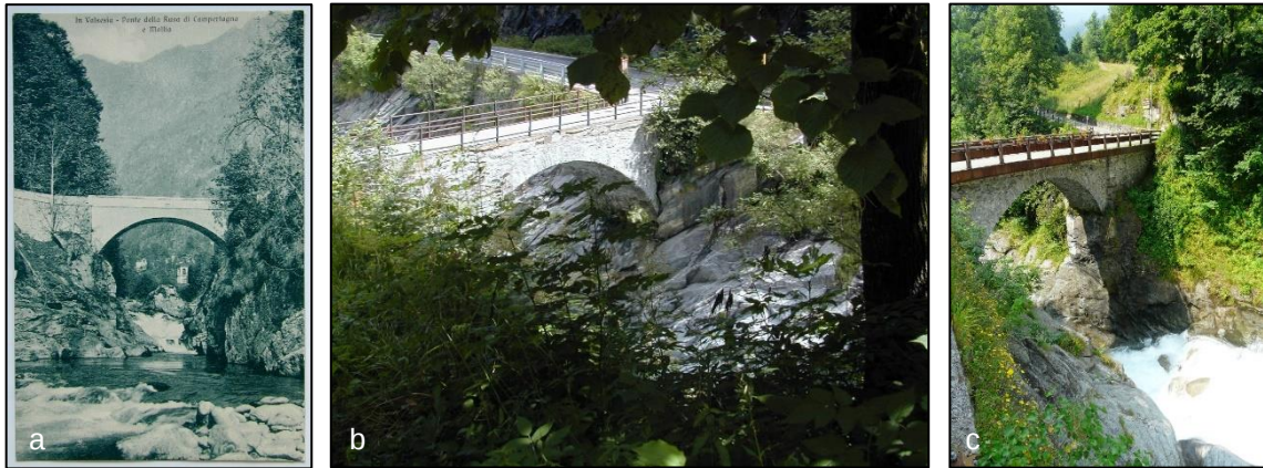
Figura 6 – Fotografie delle recenti modifiche apportate al ponte di Rusa, confrontate con la struttura originale. A sinistra il primo ponte in pietra, tutto in muratura; al centro la prima ristrutturazione con i parapetti in ferro; a destra il ponte attuale.
