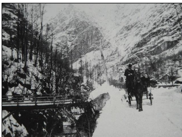
Figura 4 – Fotografia del nuovo ponte di legno, eseguita da Giuseppe Ambrogioni negli ultimi anni del XIX secolo. Si notino sotto al ponte i puntoni di rinforzo, prima inesistenti.
